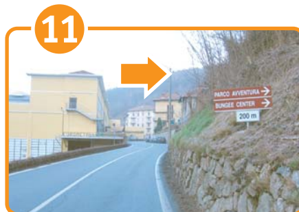
Km 39,900 Alla frazione Romanina girate a destra, in direzione di Veglio centro
