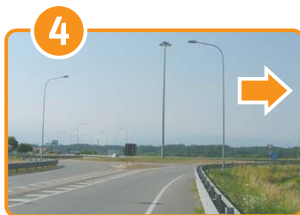
Km 4,000 Alla rotonda prendere a destra per Valle Mosso / Cossato
